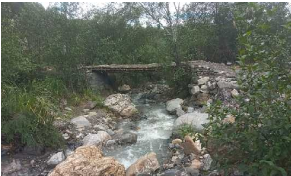
FIGURA N°02: PUENTE EXPUESTO ANTE UNA CRECIDA DEL RÍO CHORRO COLORADO POR LA FALTA DE DESCOLMATACION.
